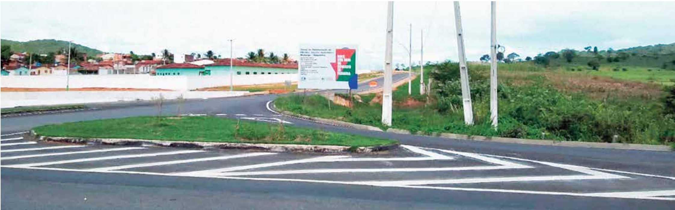
O projeto de recuperação da rodovia PB-063 é executado pelo DER-PB, tem extensão de 25,8 quilômetros e beneficiará diretamente 40 mil moradores de Gurinhém, Mulungu e Alagoinha
