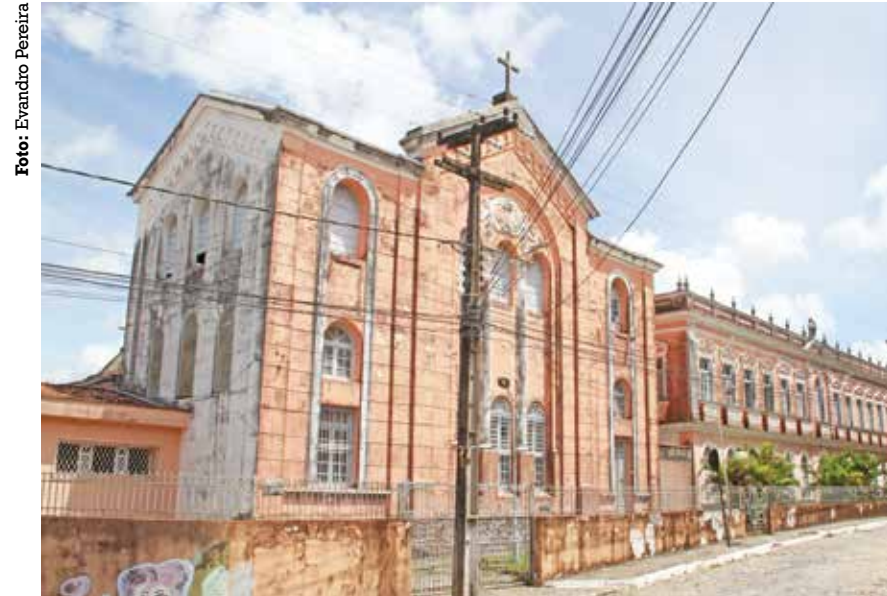
Antigo Colégio das Neves passa por obras para abrigar o parque tecnológico
