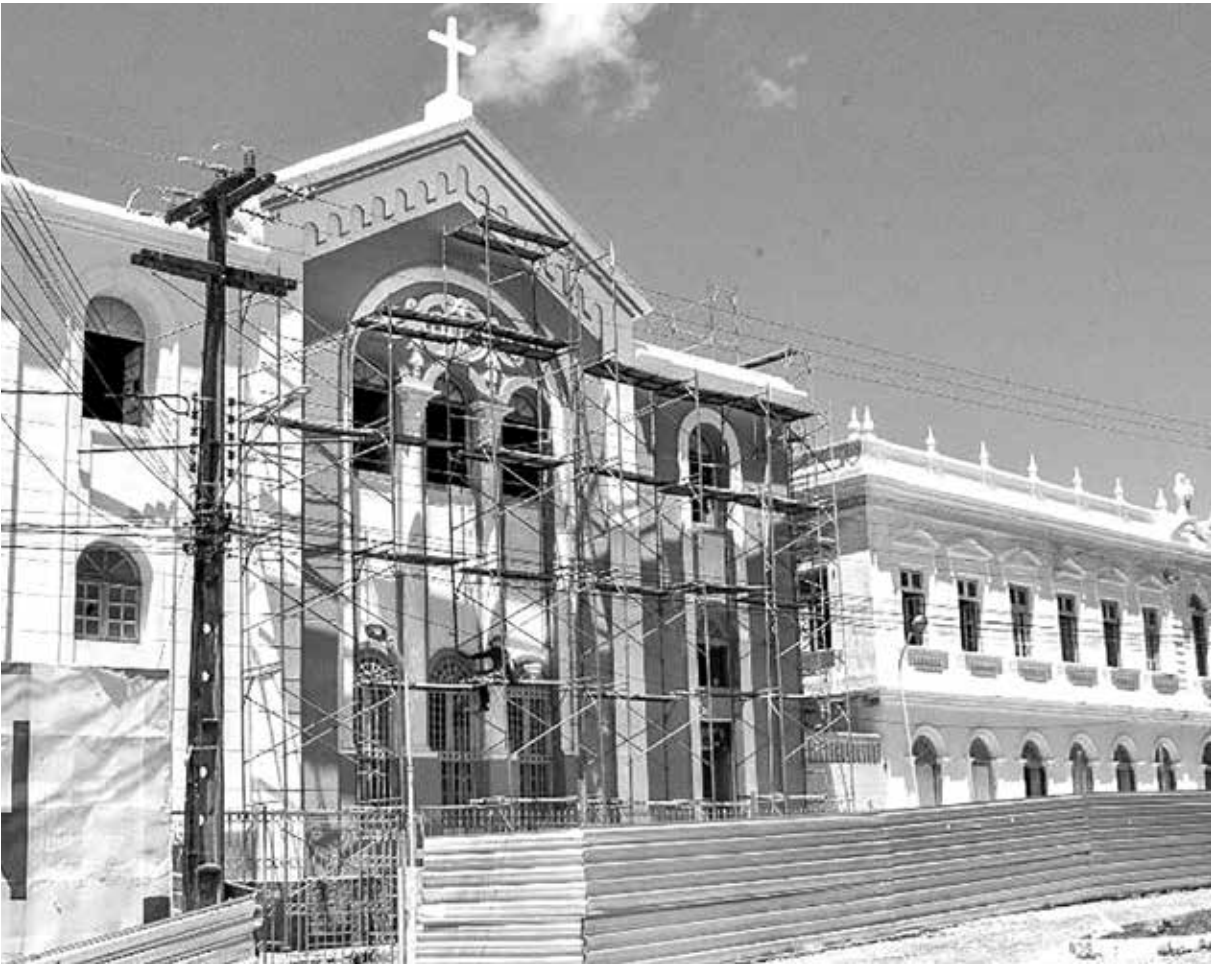
O antigo Colégio Nossa Senhora das Neves está sendo recuperado pelo Governo do Estado da Paraíba
