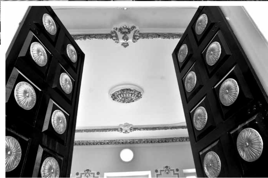
As obras de reforma não ocorreram apenas na estrutura do prédio, mas cuidaram da restauração de detalhes históricos da sede do Judiciário, que é patrimônio cultural do Estado da Paraíba
