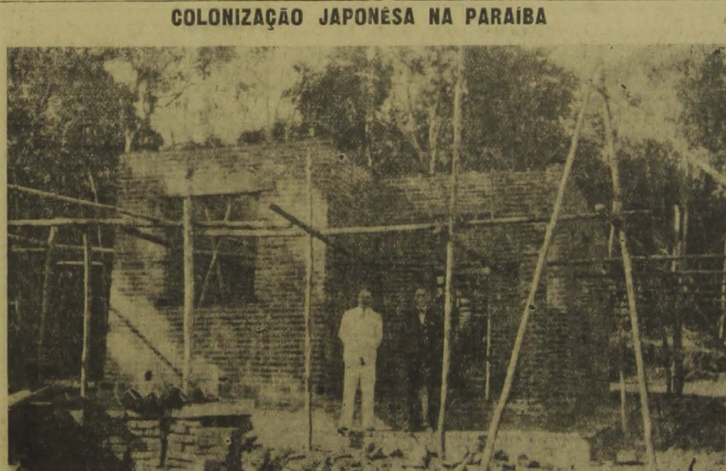
Ao fundo das casas que estão sendo construídas às proximidades de Buracinho, aparece bellissimo trecho de floresta litoranea. Aspecto de uma das casas que estão sendo construídas para os colonos japoneses, vendo-se os srs. Secretário da Agricultura e Diretor de Fomento da Produção
